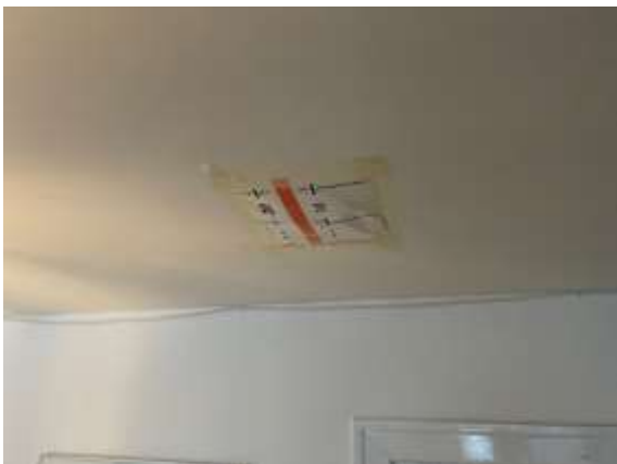
#3 Indblæsningsarmaturer er afdækket og tapet tæt.
