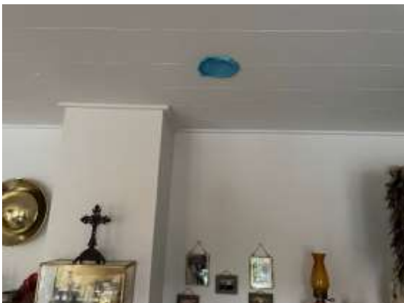
#5 Indblæsningsarmaturer er afdækket og tapet tæt.
