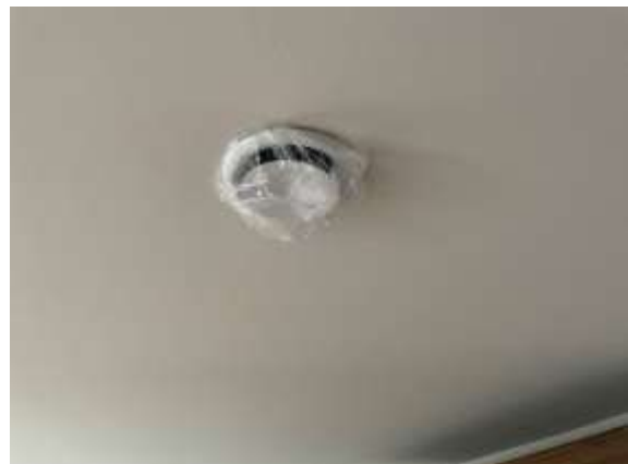
#6 Afdækning af ventil.
